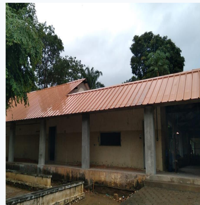
Telhas térmicas instaladas (Reitoria)
