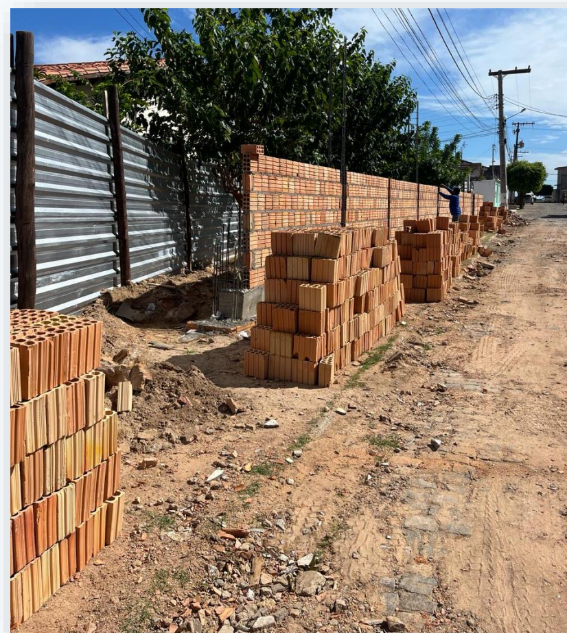
Reforma do muro – Clínica Barra
