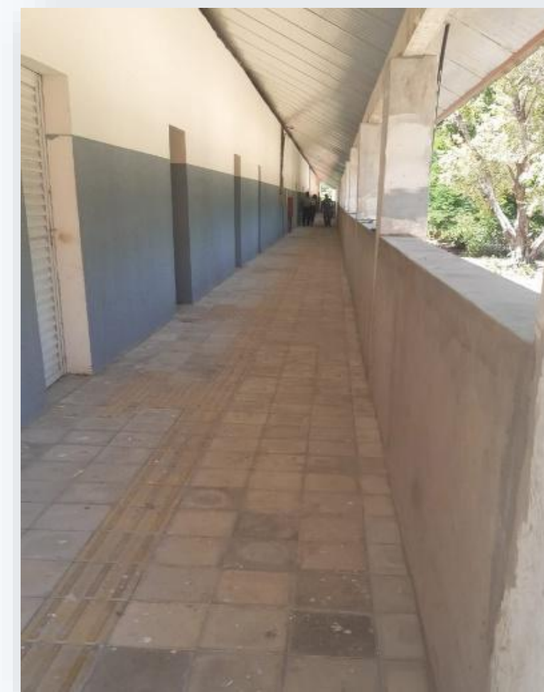
Adequações de acessibilidade na Reitoria
