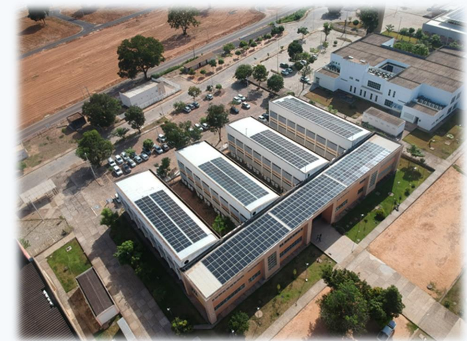
Sistema instalado sobre o Pavilhão II no CRES
