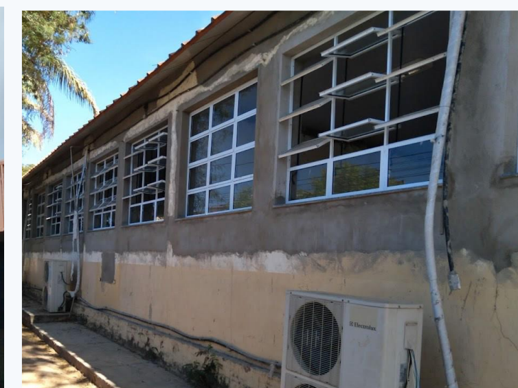
Janelas de alumínio (Reitoria)
