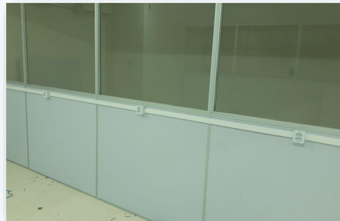
Instalação de Pontos de Lógica no LAC.
