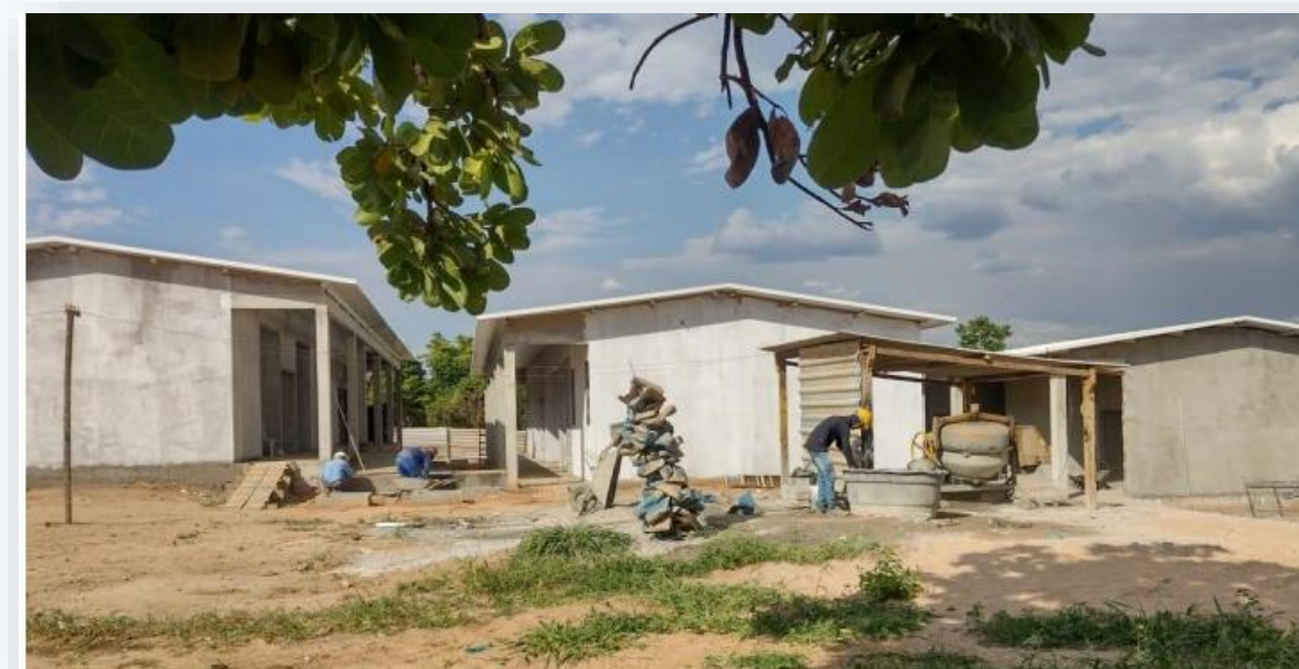
Vista da obra da CMA
