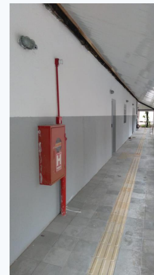
Hidrante instalado
